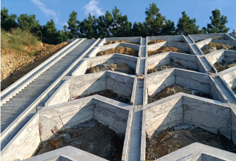
图 6 成自铁路洞口仰坡施工骨架成品效果
